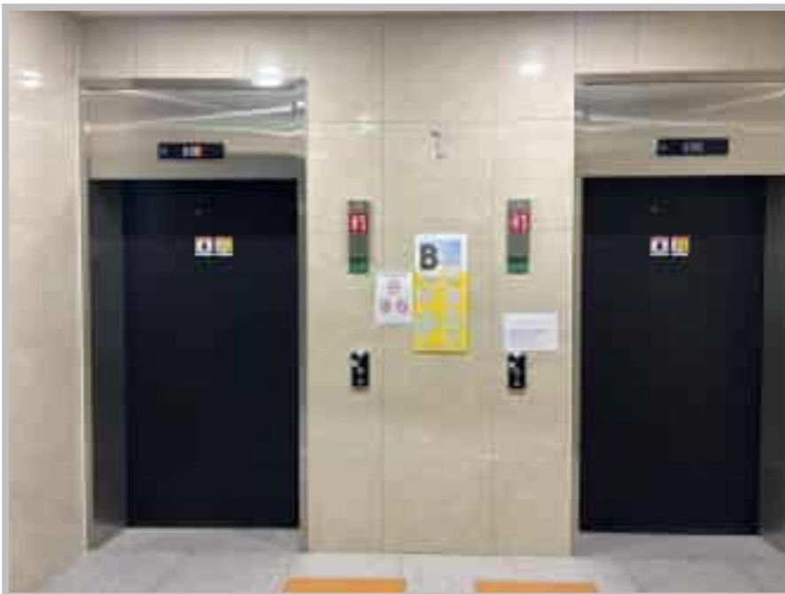
【 본건 승강기 설비 전경 】
